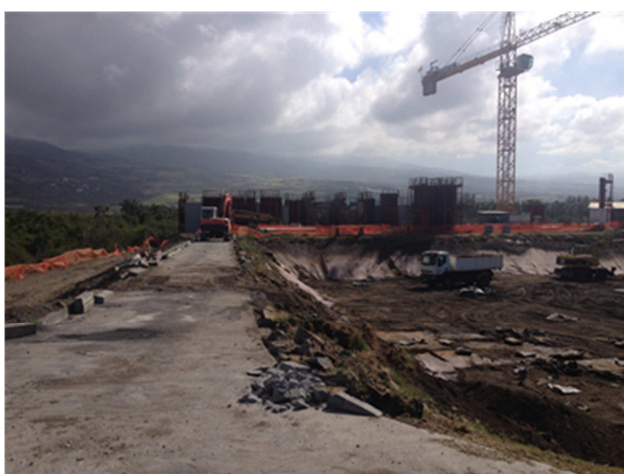
Réhabilitation de la station d'épuration de Saint-Louis, octobre 2014
