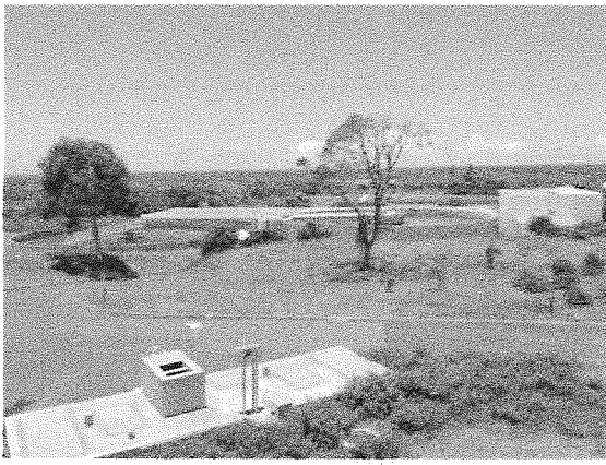
Station de traitement des eaux usées de Saint Benoît
