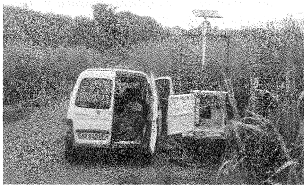
Installation d'une station piézométrique continue et télétransmise sur le forage de Ravine Blanche
